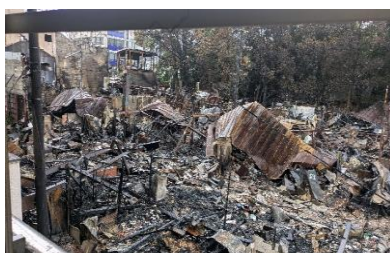
焼損区域の状況
