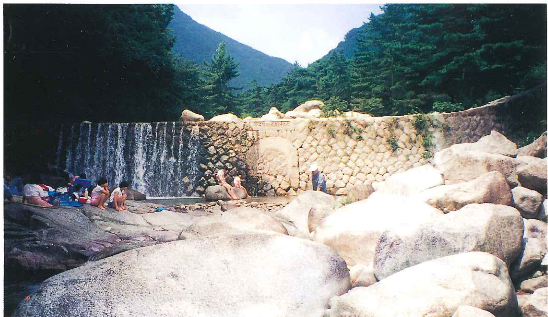
本県最初の練石積堰堤工
