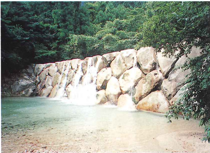
▲ 空石積 (床固工)
