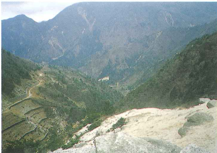
▲ 山腹工 (谷止工)
