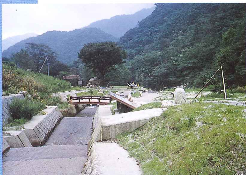
▲模型流路工（上流部より）
