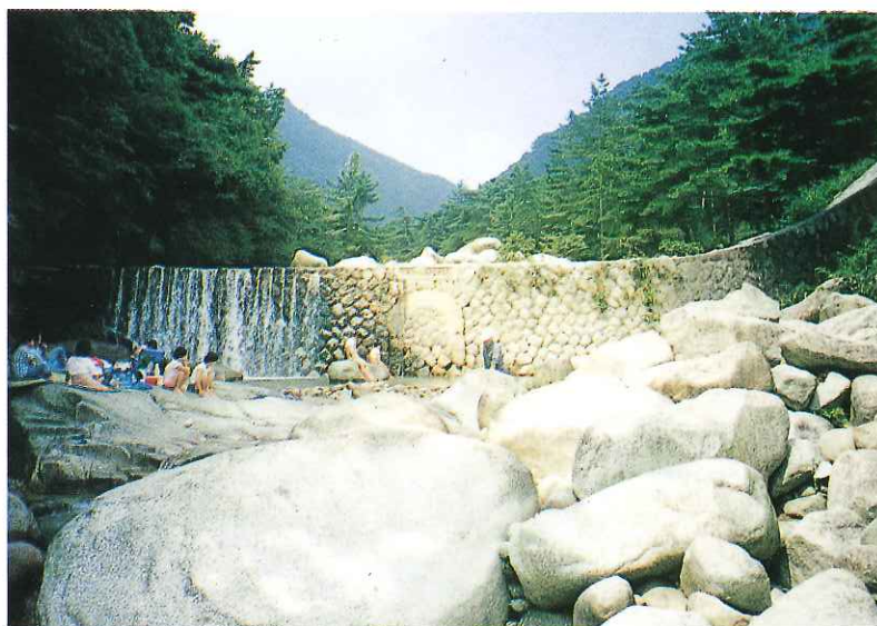
▲ 大正10年完成のダム工
