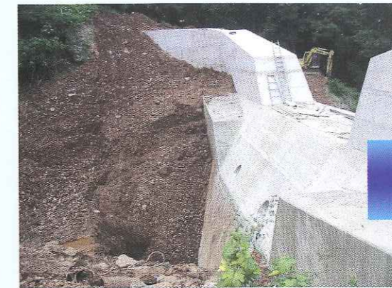
平成15年6月 ■西之貝戸川1号えん堤の土石流捕捉状況
