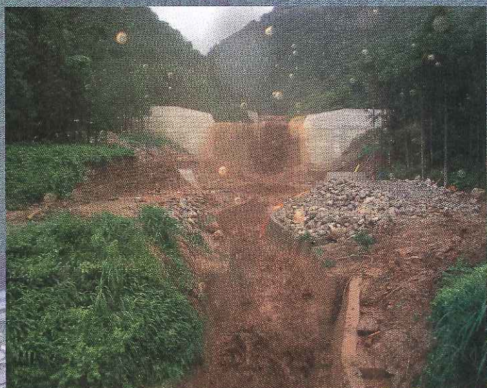
■ 流下中の土石流:小滝川1号えん堤(平成14年7月17日撮影)
