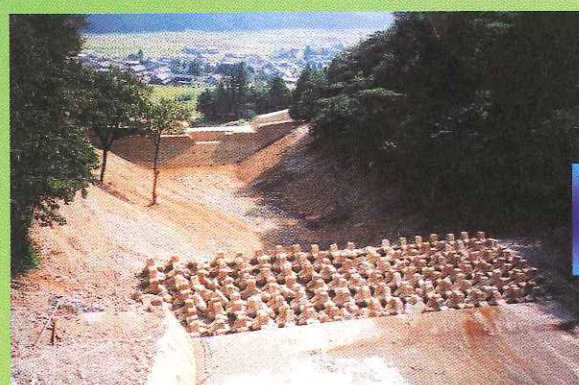
平成14年9月 ■小滝川1号えん堤の土石流捕捉状況
