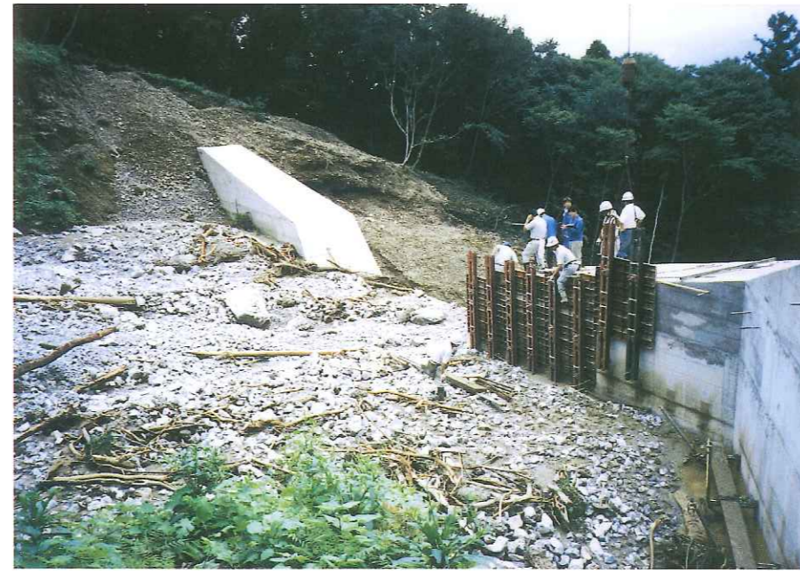
土石流の流下をくい止めた1号砂防
