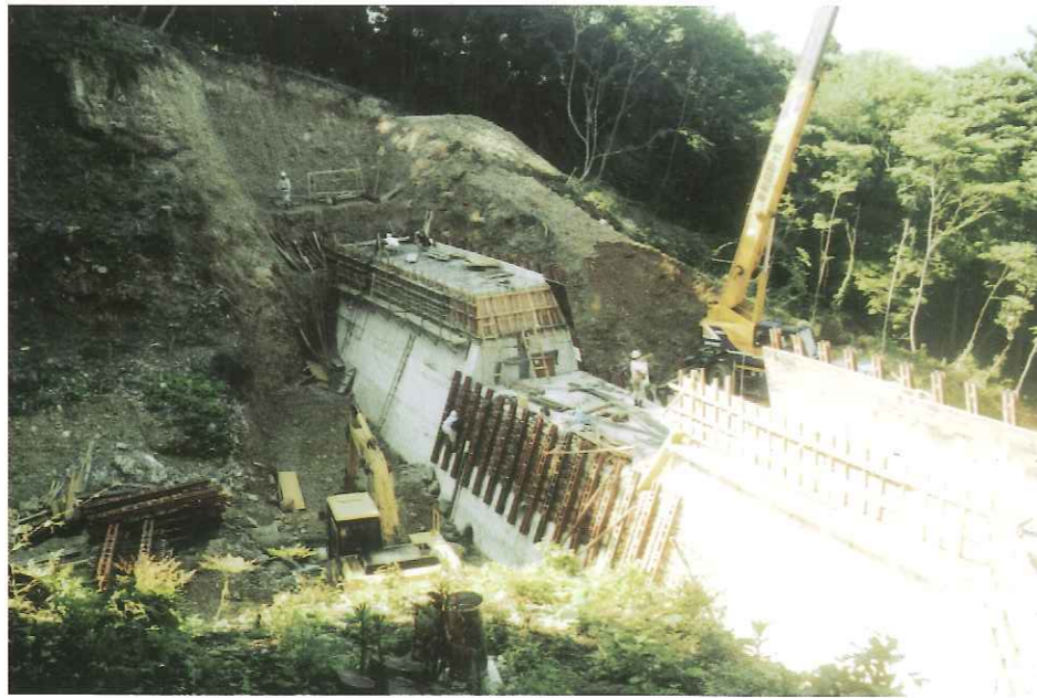
建設工事中の1号砂防ダム(平成11年3月1日着工)
