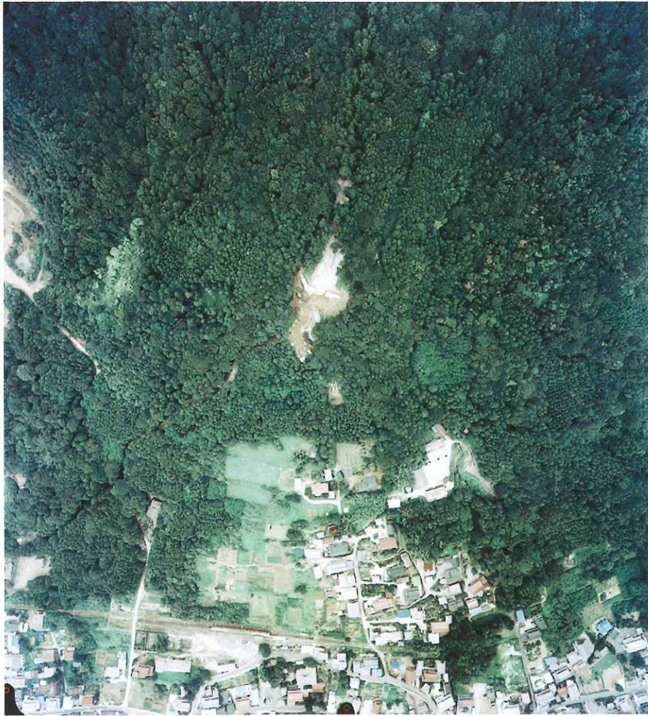
土石流を捕捉した1号砂防ダムと市街地
