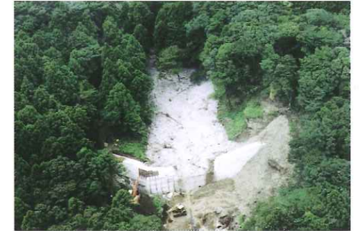
土石流の流下をくい止めた1号砂防
