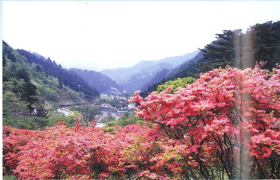
ダム堆砂域上流より下流を望む
