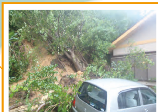
19 矢口浦4(北牟婁郡紀北町海山区矢口浦) 被害状況：一部損壊1戸
