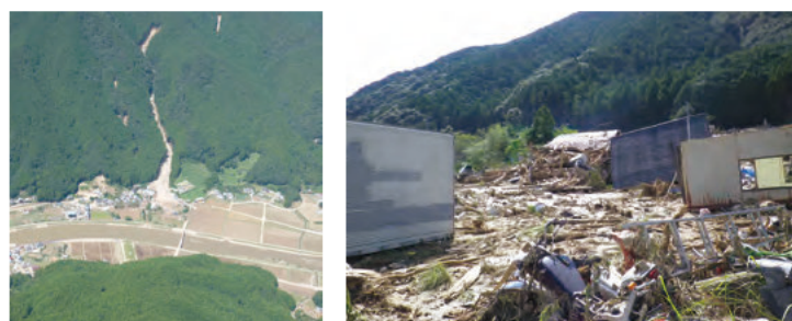
33 ジャングの谷(ジャングのたに) 南牟婁郡紀宝町高岡 被害状況：全壊5戸、半壊3戸、一部損壊2戸
