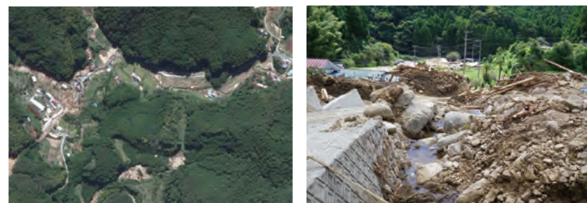
20 茗荷古(みょうがふる) 熊野市井戸町大馬 被害状況：全壊1戸
