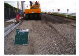
再生砕石(RC-40)を路盤材として利用 鈴鹿建設事務所(鈴鹿市)
