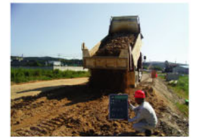
熊野建設事務所 (熊野市)
