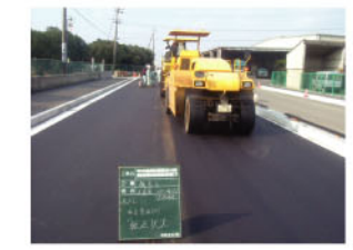
再生アスファルトを用いた道路舗装 伊賀建設事務所(名張市)
