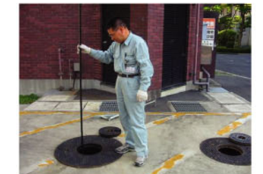
地下オイルタンク定期点検(本庁舎)
