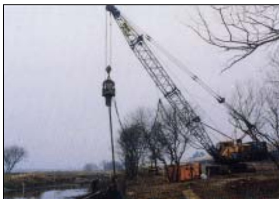
大型機械による樹木越しの施工（長良川）
