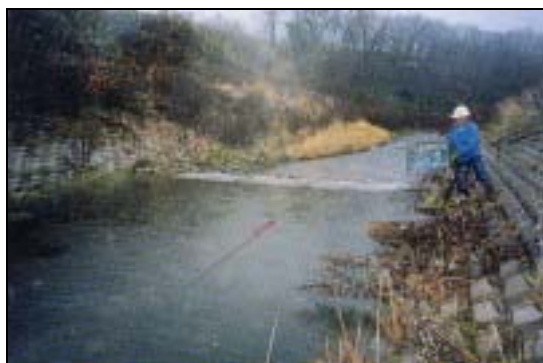
河道に簡易な堰を設けて濁水の流出を低減した例（登川）
