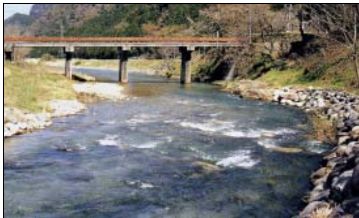
八東川 施工後3年
