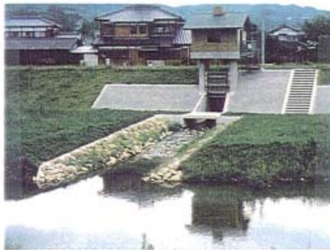
▲樋管出口はもちろんのこと樋管内の構造も工夫する。
