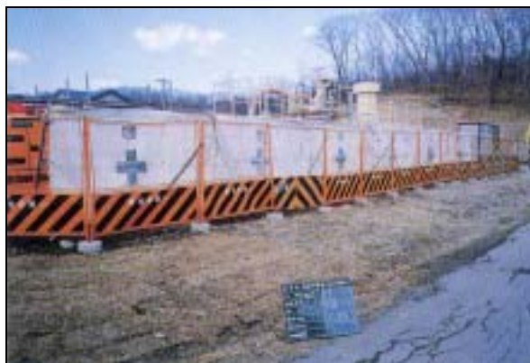
現場の騒音対策の例（有珠川）
