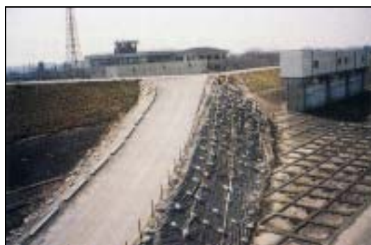
搬入路に舗装、シート掛けをして土砂・濁水流出を防止した例（利根川）
