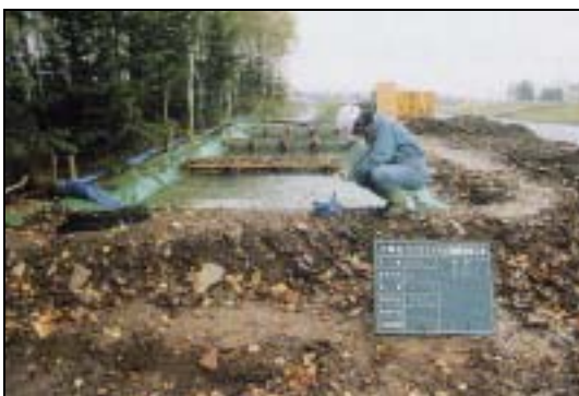
仮設のろ過施設を設けて濁水の流出を防止した例（パツナイ川）
