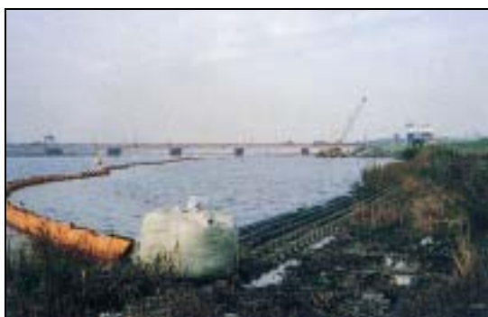
水中に濁水防止フェンスを敷設した例（荒川）
