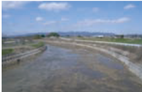
堆積土砂撤去後の河川
