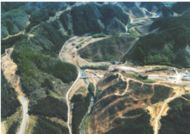
川上ダム建設予定地
