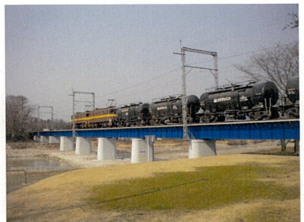
【同橋梁修繕後】
