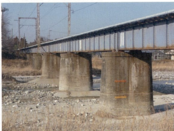
【三岐鉄道 宇賀川橋梁 橋脚修繕前】
