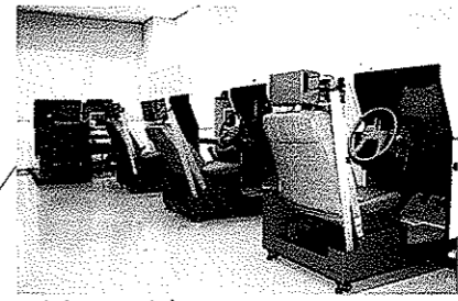
▲シミュレータ室
