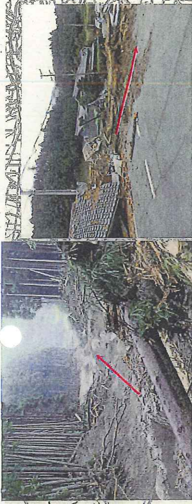
①津市美杉村石名原 字所谷 山腹崩壊(表層)による土石流が発生し、下流集落が被災。
