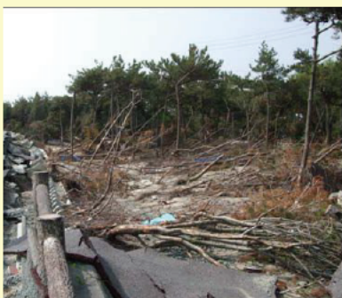
津波により倒伏した海岸防災林
