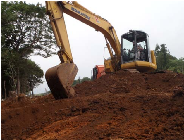
重機による表土掘削の様子です
