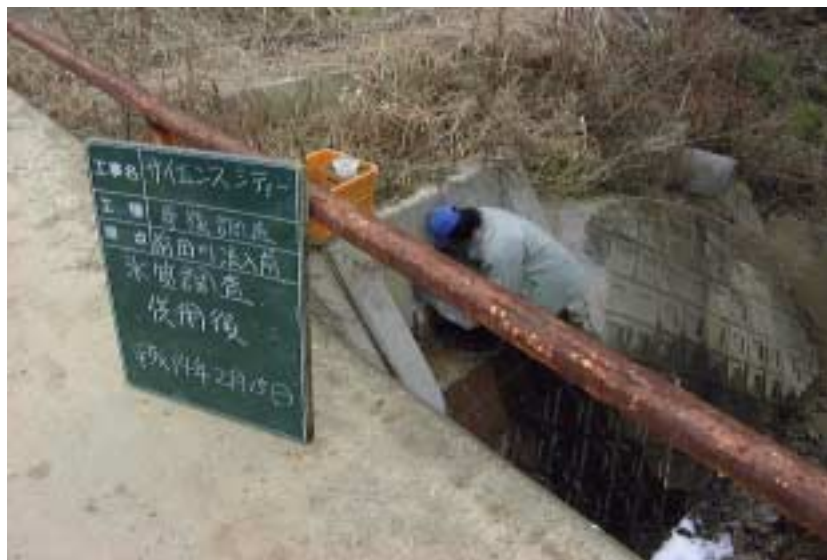
写真4 - 167 供用後排水調査状況（サイレスリター前田川側）（平成14年2月15日）
