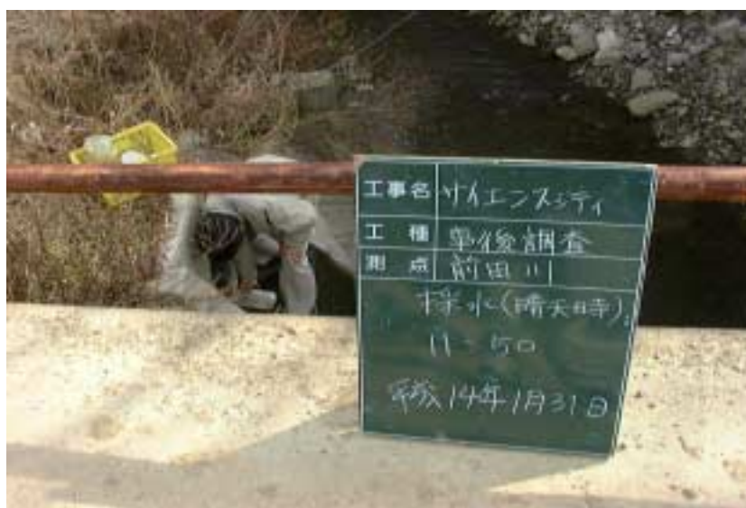
写真4 - 166 供用後排水調査状況 (サイエンス前田川側) (平成14年1月31日)
