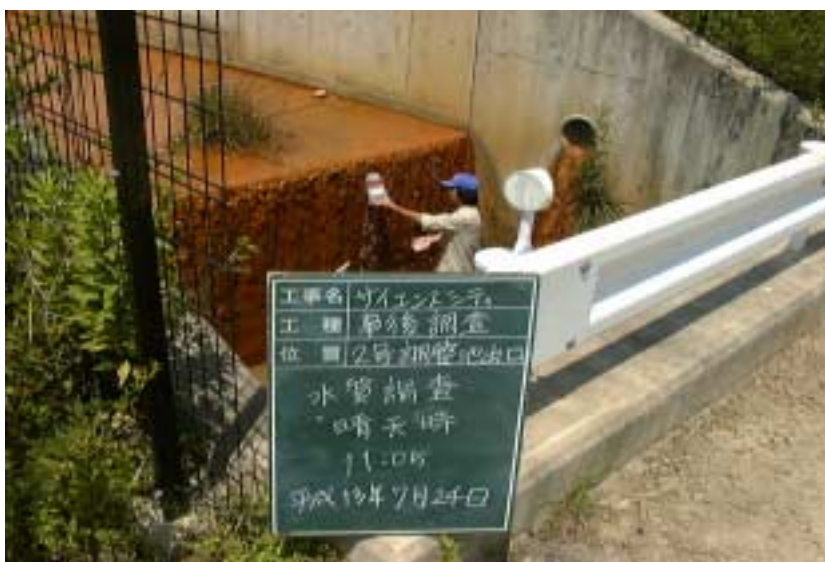
写真4 - 156 農業用水調査状況(2号調整池出口)(平成13年7月24日)
