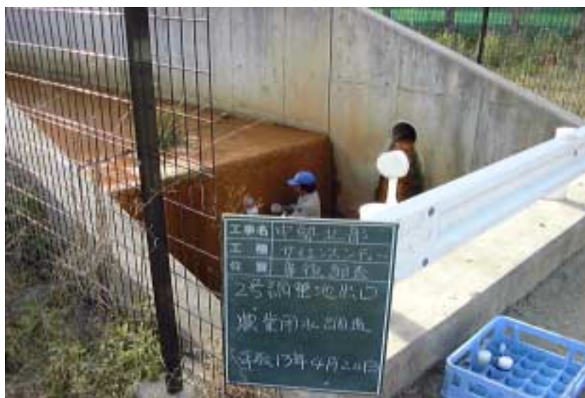
写真4 - 154 農業用水調査状況（2号調整池出口）（平成13年4月20日）
