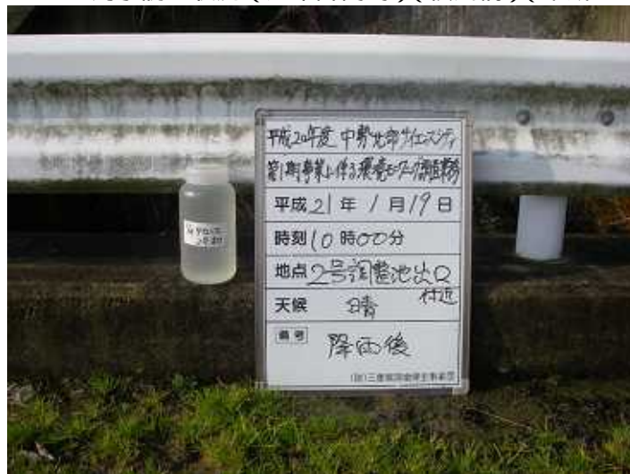
写真4 - 1 - 29 濁水調査状況（通常降雨時）（2号調整池出口付近）（平成21年1月19日）
