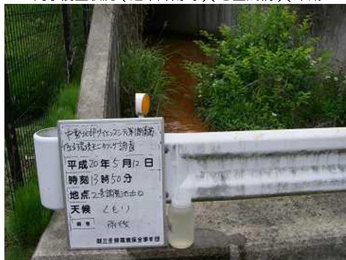
写真4 - 1 - 3 濁水調査状況（通常降雨時）（2号調整池出口付近）（平成20年5月12日）
