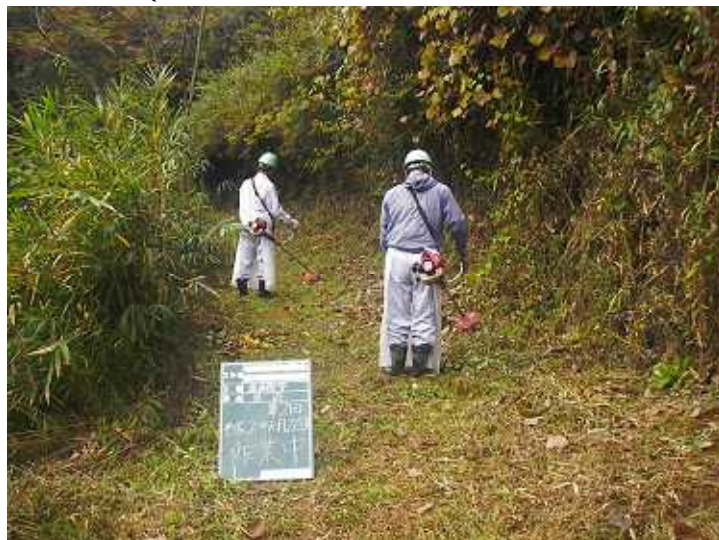
写真4 - 3 - 17 整備状況 (除草工：除草作業中・保全区域A・通路：平成20年10月22日)
