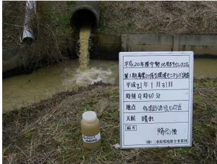
写真4 - 1 - 55 濁水調査状況（豪雨時）（仮設沈砂池出口付近）（平成21年1月31日）
