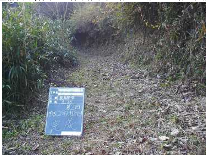
写真4 - 3 - 18 整備状況 (除草工：除草後・保全区域A・通路：平成20年10月27日)
