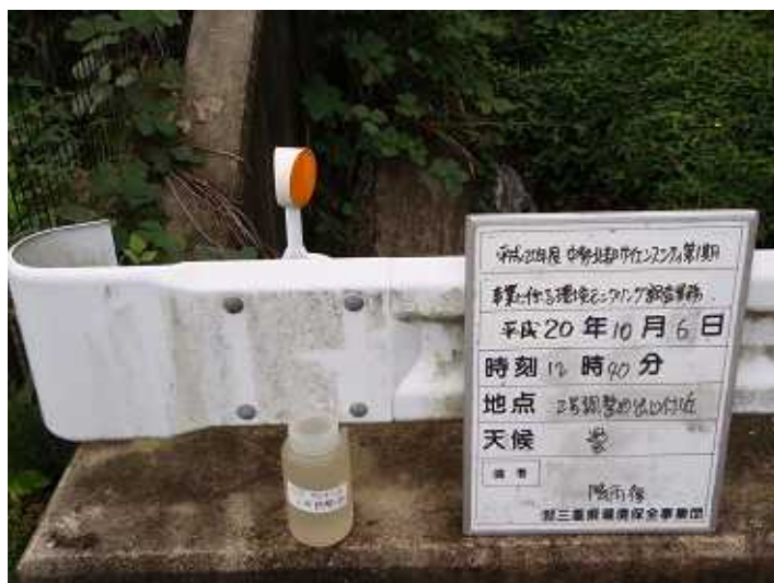
写真4 - 1 - 19 濁水調査状況（通常降雨時）（2号調整池出口付近）（平成20年10月6日）
