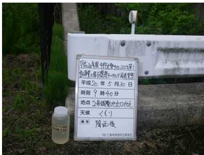
写真4-1-7 濁水調査状況（通常降雨時）（2号調整池出口付近）（平成20年5月30日）
