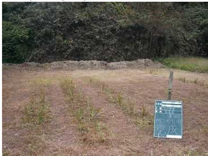
写真 4 - 3 - 15 整備状況 (除草工 (人力): 除草後・ハシヨウフ 植栽地 : 平成 20 年 9 月 30 日)
