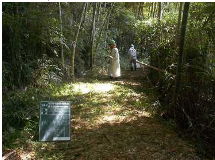
写真4 - 3 - 5 整備状況（除草工：除草作業中・保全区域A・通路：平成20年7月22日）
