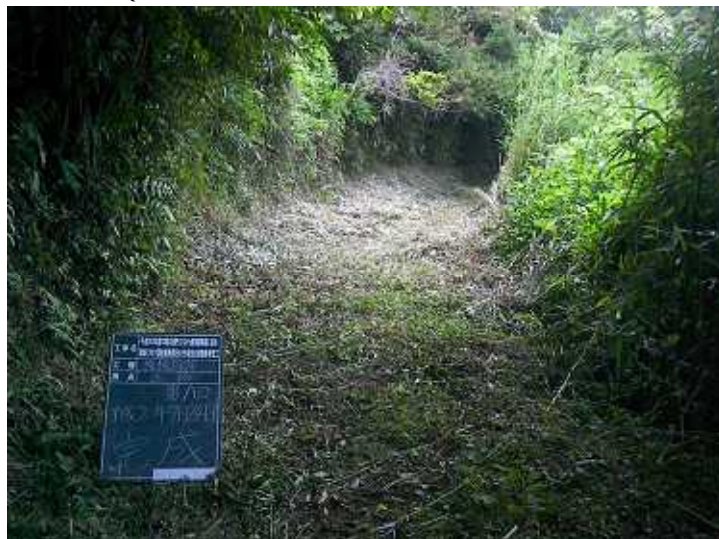
写真4 - 3 - 6 整備状況（除草工：除草後・保全区域A・通路：平成20年7月24日）
