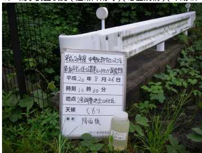
写真 4 - 1 - 11 濁水調査状況（通常降雨時）（2号調整池出口付近）（平成 20 年 8 月 26 日）
