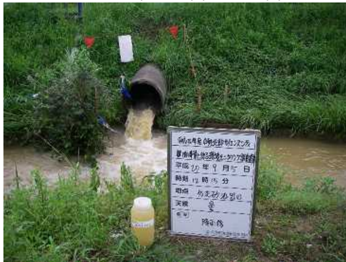
写真 4 - 1 - 51 濁水調査状況（豪雨時）（仮設沈砂池出口付近）（平成20年9月5日）
