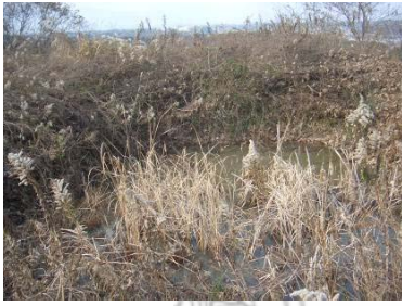
【窪地】素掘りの旧調整池
