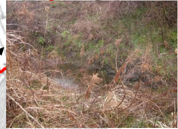
【窪地】素掘りの旧調整池 降雨後に水が溜まり、徐々に地下に浸透している。
