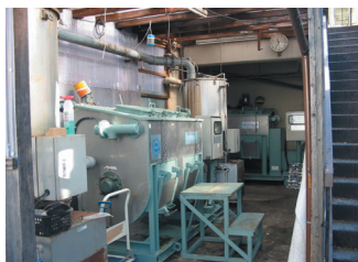
生ごみ処理品を飼料化（ペレット化）
