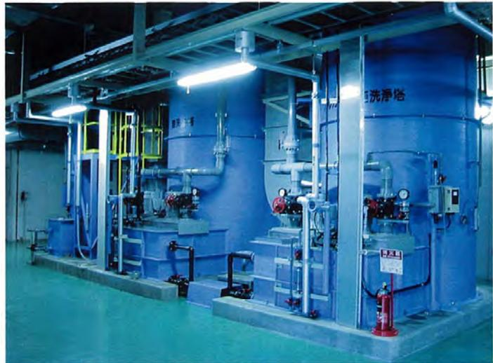
脱臭装置 高濃度臭気:生物脱臭+薬液洗浄+活性炭吸着
