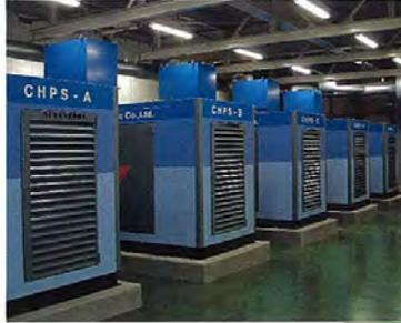
発電機 デュアル燃料エンジン80kW×5基、廃熱も回収して熱エネルギーとして利用します。
