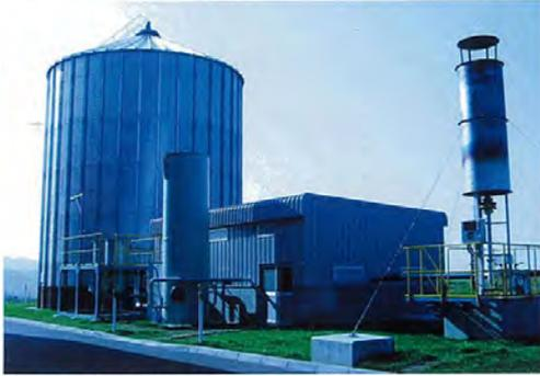
ガスホルダー、脱硫装置 ガスホルダー容量1,000m<sup>3</sup>、メタンガスを一時貯留して脱硫装置にて硫化水素を除去します。
