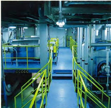
脱水乾燥室 汚泥脱水機3台、乾燥機1台
