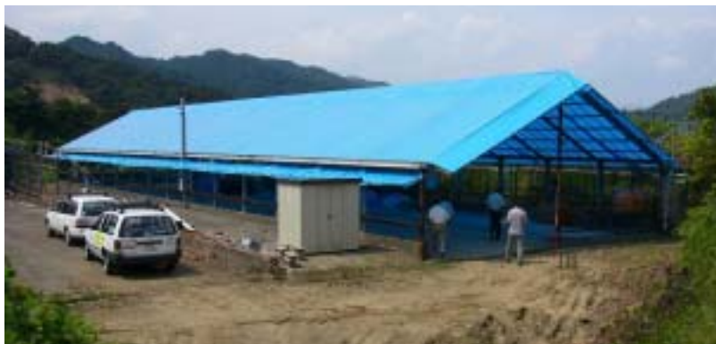
生ごみ堆肥化実験場(全景)
