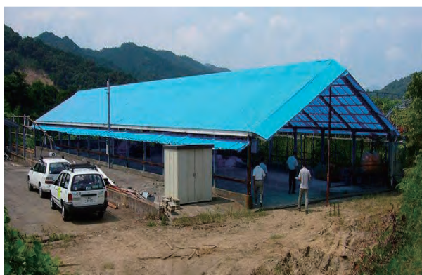
↑ 生ごみ堆肥化実験処理施設 (全景)
