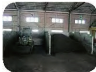
堆肥化施設の内部
