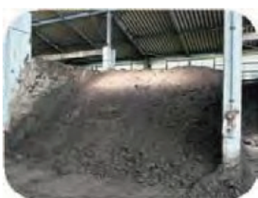
堆肥化施設の内部
