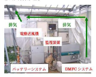
写真1 燃料電池システムの構成
