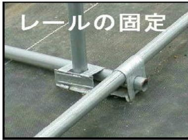
図3 横柵に横架したレール用パイプ
