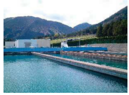
沈でん池(北中勢水道 水沢浄水場)
