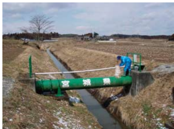
【工業用水道施設・管路の点検】
