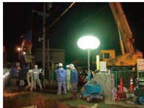
夜間の漏水復旧作業
