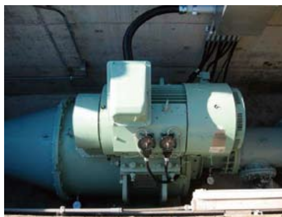
【小水力発電設備】
