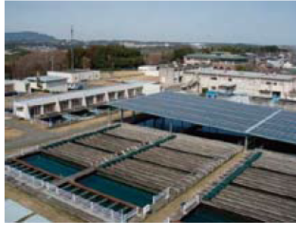
浄水場(北中勢水道 高野浄水場)
