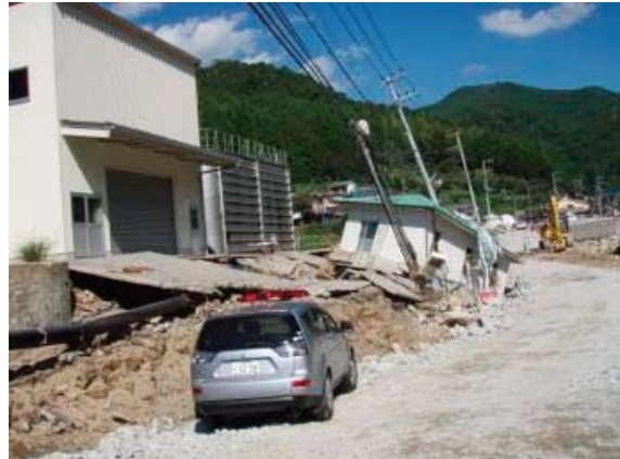
【浄水施設の被災状況(熊野市)】
