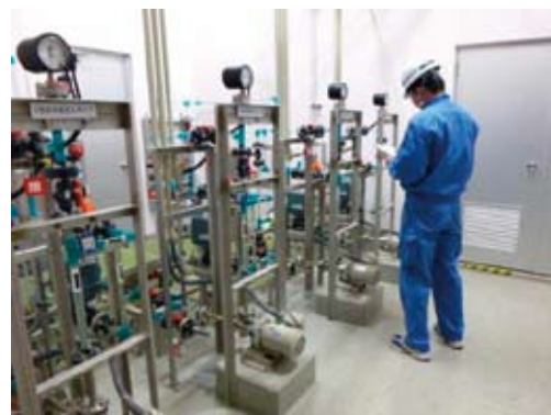
薬品注入設備の点検
