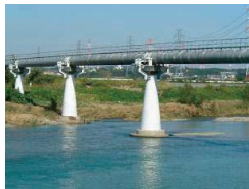
耐震補強後の水管橋
