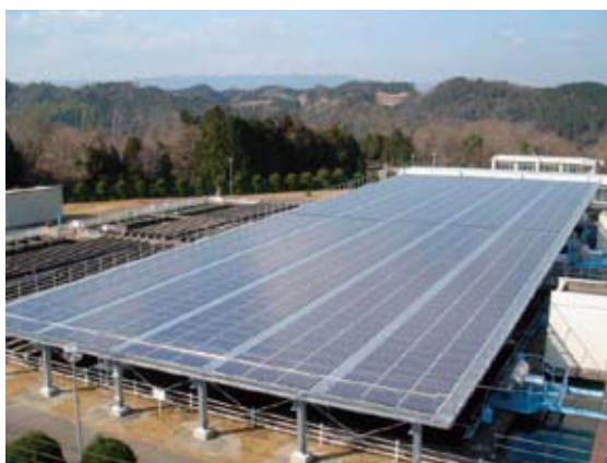
【太陽光発電設備】
