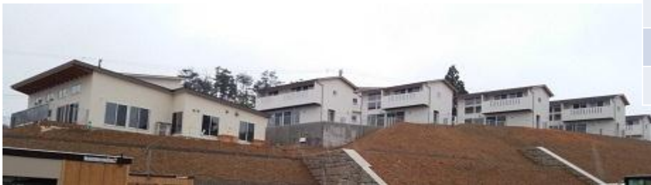
南三陸町の災害公営住宅
