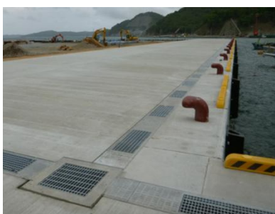
復旧状況（女川漁港）
