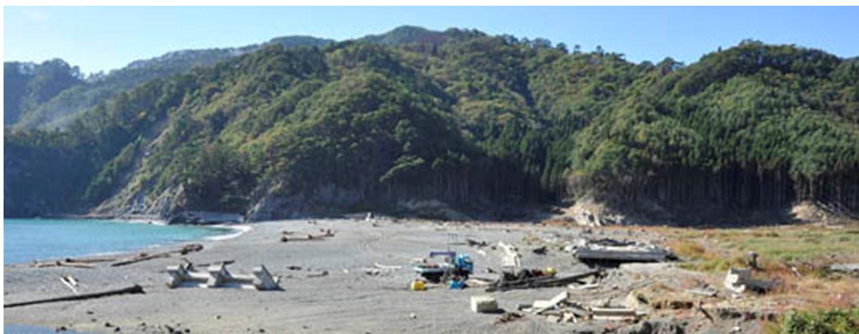
(山田町小谷鳥地区の全壊した海岸堤防跡)
