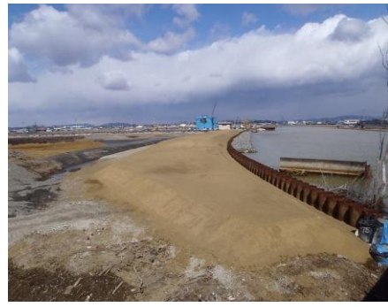
定川の工事途中の築堤
