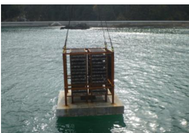
復旧状況（漁場造成）
