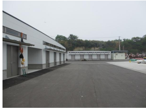
復旧した漁具倉庫（七ヶ浜町）
