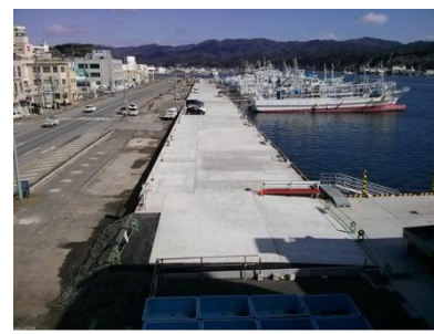
復旧状況（気仙沼漁港）
