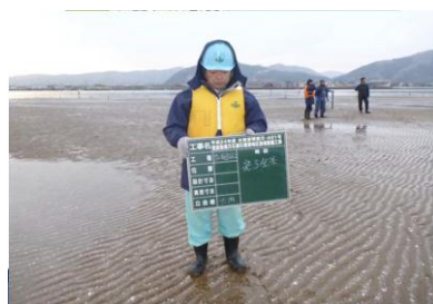
復旧状況（干潟造成）
