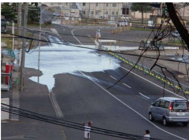
写真1 潮汐による道路冠水の状況
