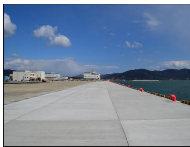
復旧状況（石巻漁港）
