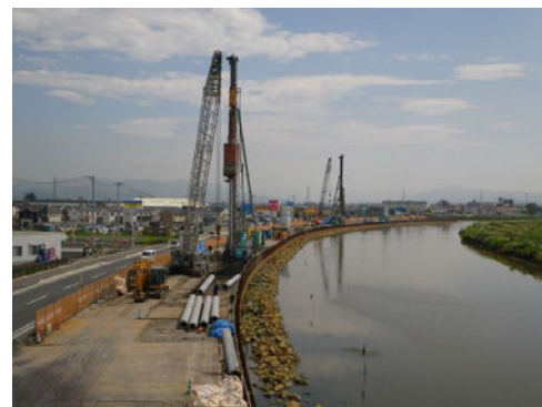
定川の左岸基礎工事
