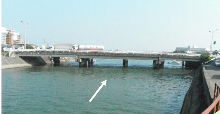
国道23号江戸橋
