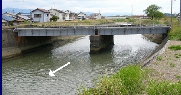
近鉄橋梁 (流下能力ネック地点)
