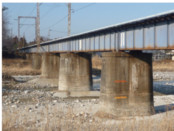
【三岐鉄道 宇賀川橋梁 橋脚修繕前】
