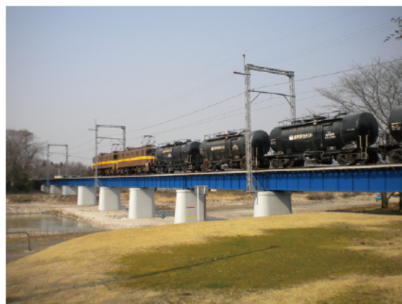
【同橋梁修繕後】
