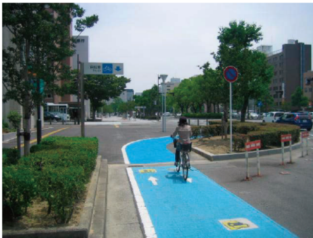
■自転車専用レーン(四日市市)
