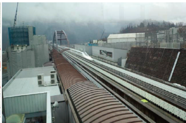
■超電導リニア走行試験の様子
