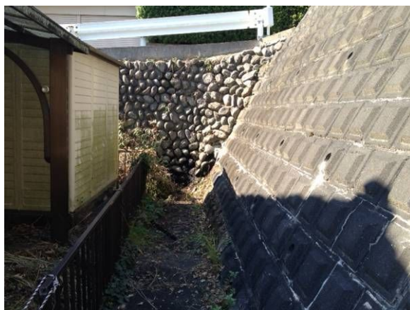
写真左側：旧公舎、右側：擁壁
