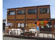
仮設による復興食堂（岩手県）
