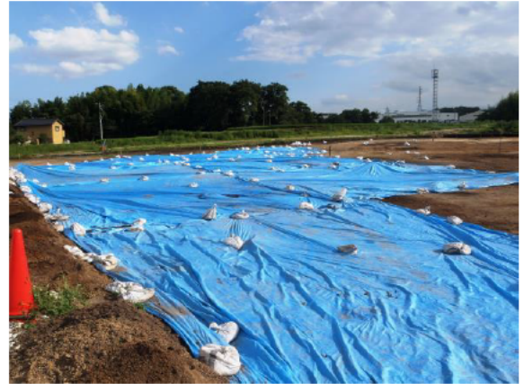
掘削・調査が終了した所にはシートをかぶせて形状を保存しておきます。現地説明会で公開します。
