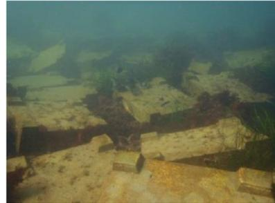
図2. 沈設されたコンクリート板
