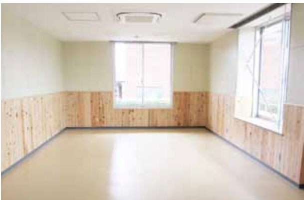
写真-2. 新設した会議室（壁にはスギ板を使用）
