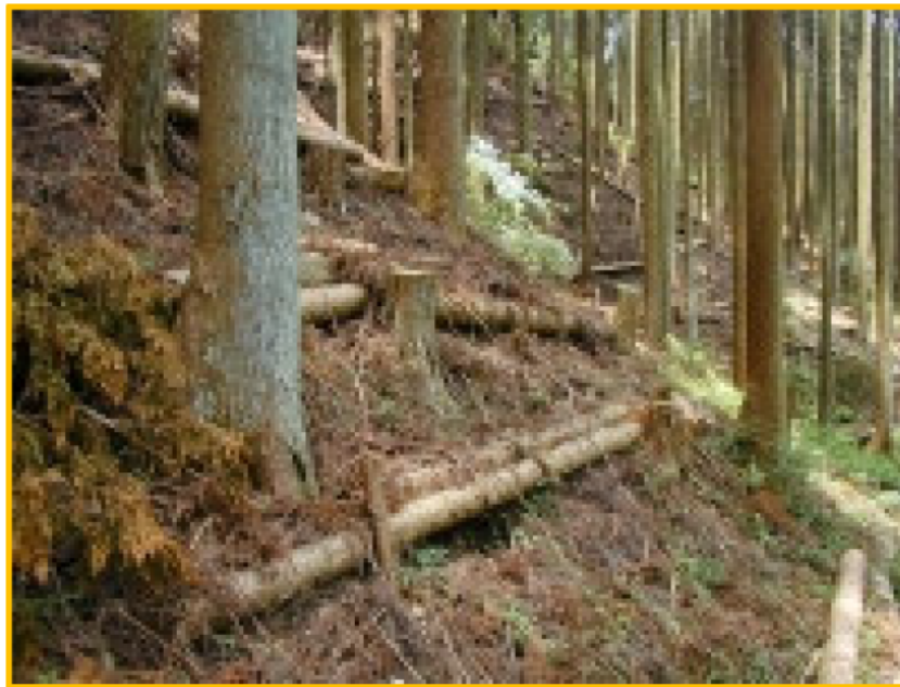
伐倒木を利用した土砂止の設置
