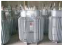
高圧トランス
