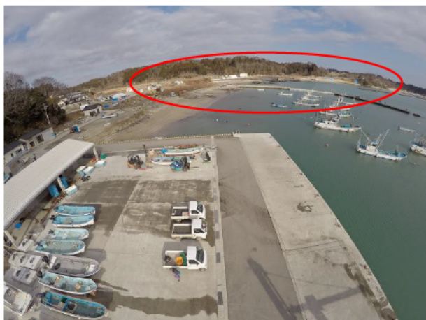
稲渚および長須賀施工箇所周辺状況 南三陸町：平成27年1月撮影
