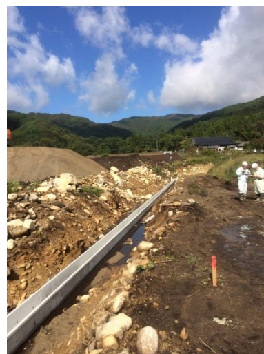
復興基盤総合整備事業吉浜地区（大野工区）。地籍調査実施済。平成26年10月7日撮影。
