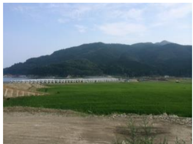
右側：復興基盤総合整備事業吉浜地区、左側：消波ブロックの奥が農地海岸保全施設災害復旧事業吉浜海岸（大船渡市）。平成 26 年 7 月 31 日撮影。
