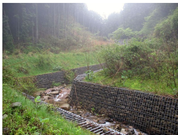
水土保持施設の整備（鋼製護岸）
