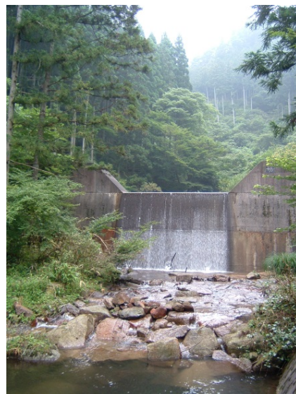
コンクリート谷止工
