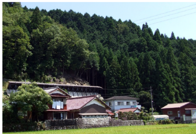
落石防護壁工
