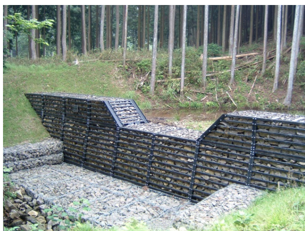
水土保持施設の整備（鋼製ダム）
