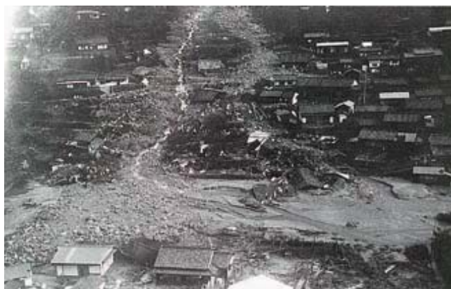
小浜川土石流（尾鷲市賀田町）
