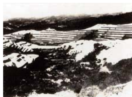
(工種) 積苗工粗朶伏工 昭和8年施工
