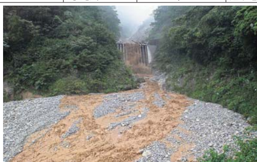
小滝川(4号堰堤)平成24年9月18日土石流発生後
