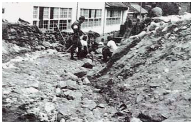
宇谷川 (津市美杉町八知) 台風の出水による山地崩壊により流出した土砂のため埋没した小学校
