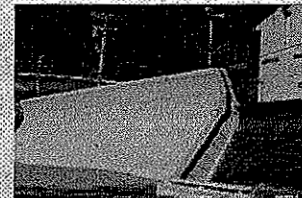
漁港海岸堤防の防災対策
