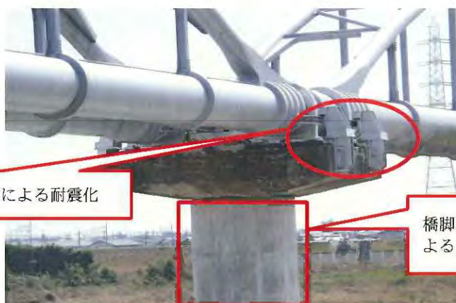
水管橋耐震補強工事（鈴鹿川第2水管橋）
