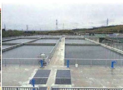
沈殿池完成後
