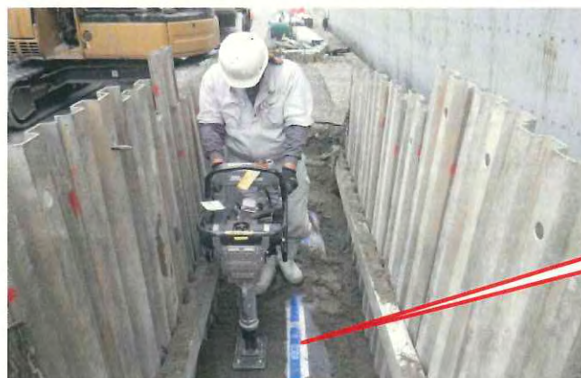
配水管複線化工事（φ300 耗配水管）
