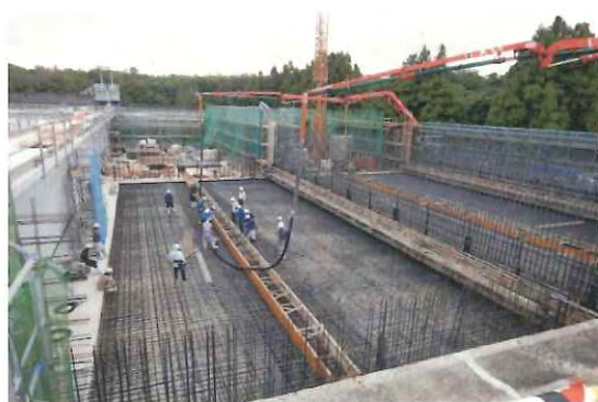
沈殿池コンクリート打設状況
