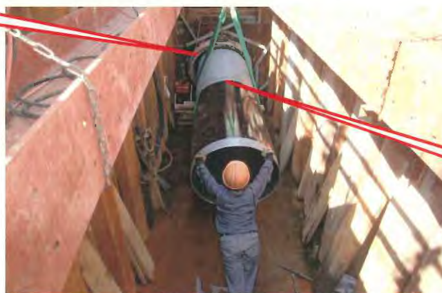
配水管（PC管）更生工事
