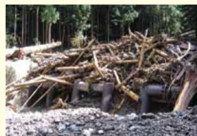
治山ダム等に堆積した土砂・流木の撤去や流木になる恐れのある立木を除去します
