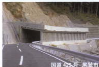
国道 425 号 尾鷲市
