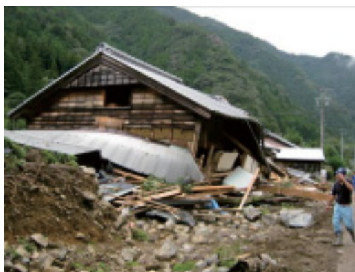
山腹崩壊（表層）による被害
