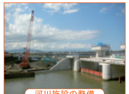
河川施設の整備
