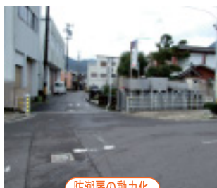
防潮扉の動力化
