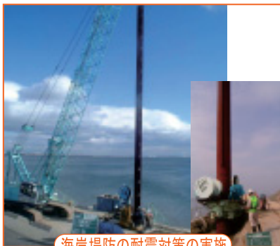
海岸堤防の耐震対策の実施
