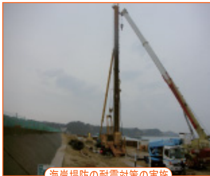
海岸堤防の耐震対策の実施
