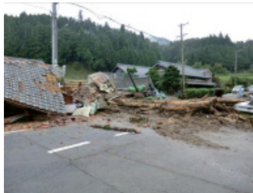
山腹崩壊（表層）による被害
