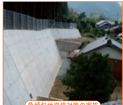
急傾斜地崩壊対策の実施
