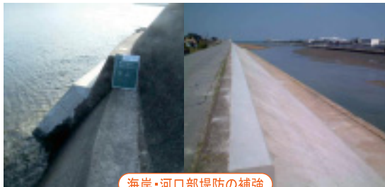
海岸・河口部堤防の補強
