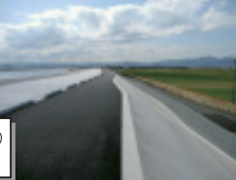
三雲地区（鶴工区）整備済み箇所
