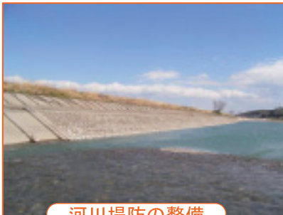
河川堤防の整備
