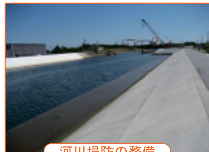
河川堤防の整備
