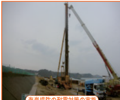
海岸堤防の耐震対策の実施
