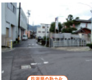
防潮扉の動力化
