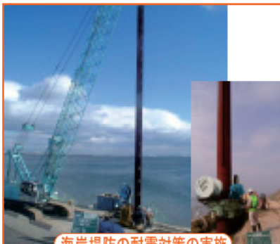
海岸堤防の耐震対策の実施
