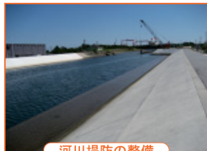
河川堤防の整備
