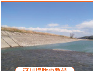
河川堤防の整備
