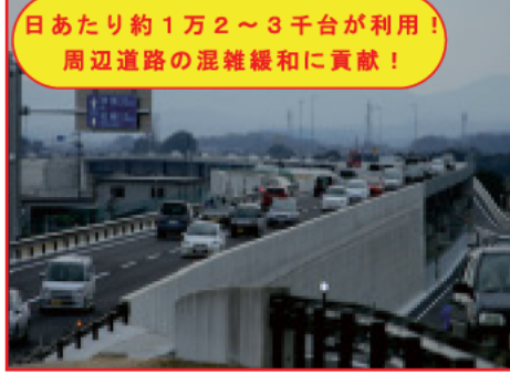
H24.2.5 供用区間の状況
