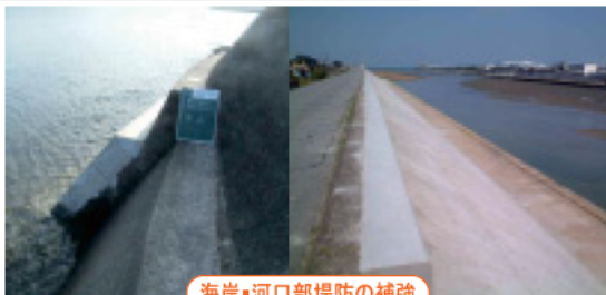
海岸・河口部堤防の補強
