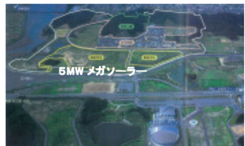
伊勢二見メガソーラー光の街（伊勢市） （平成25年夏頃稼働予定、容量5,000kW）
