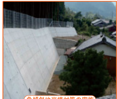
急傾斜地崩壊対策の実施
