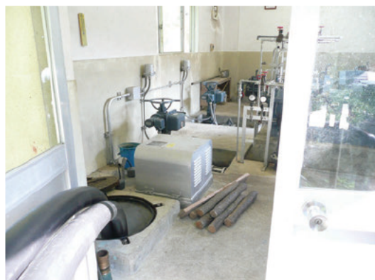
【水没したポンプ室の状況】（紀宝町）
