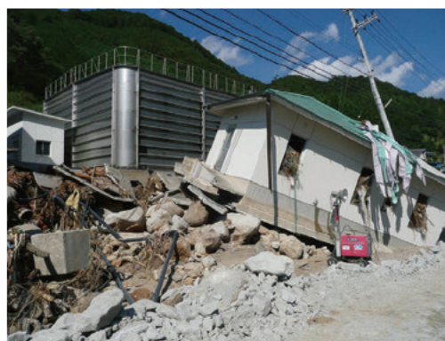
【ポンプ室の被災状況】（熊野市）
